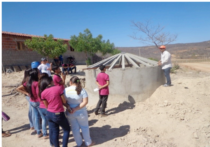
Figura 3 – Investigadores identificando elementos matemáticos na construção de cisternas.
