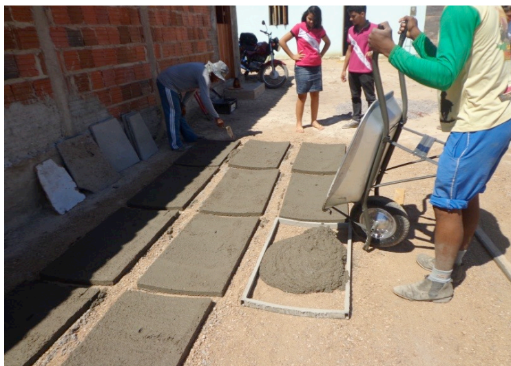
Figura 5 – Processo de confecção das placas da cisterna.
